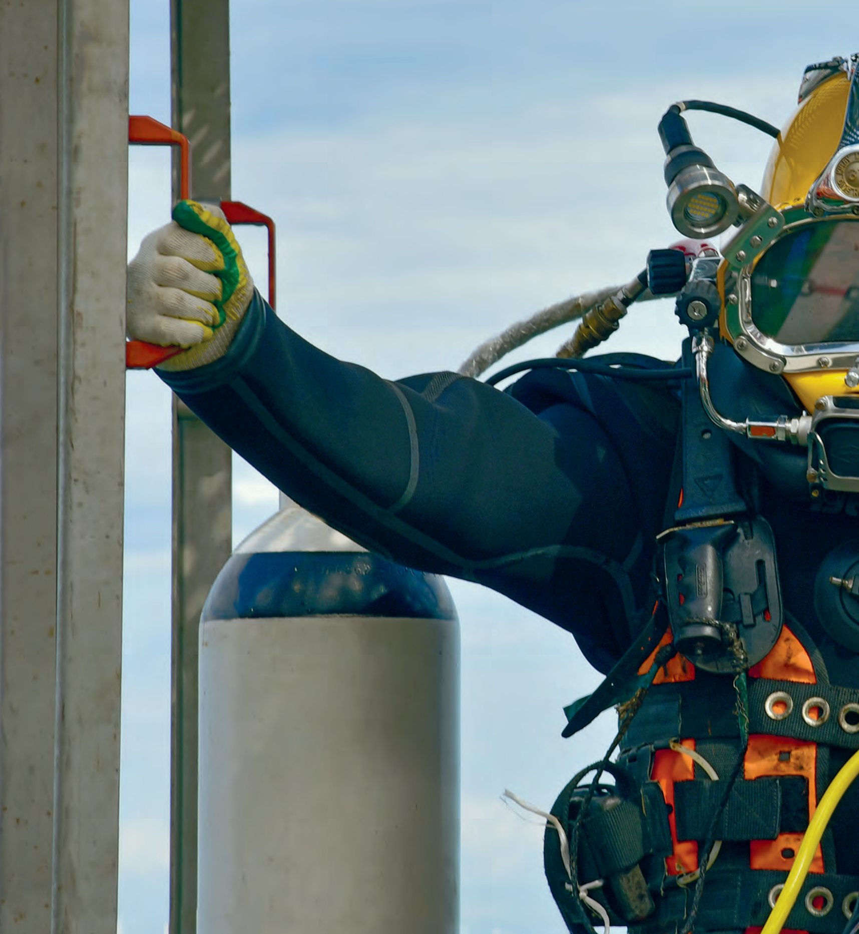
Подготовка к подводной резке корпусов танкеров «Волгонефть-212» и «Волгонефть-239». Керченский пролив, июль 2025 года. Автор: Александр Ханенко, заместитель директора по производству Азово-Черноморского филиала ФГБУ «Морспасслужба»
