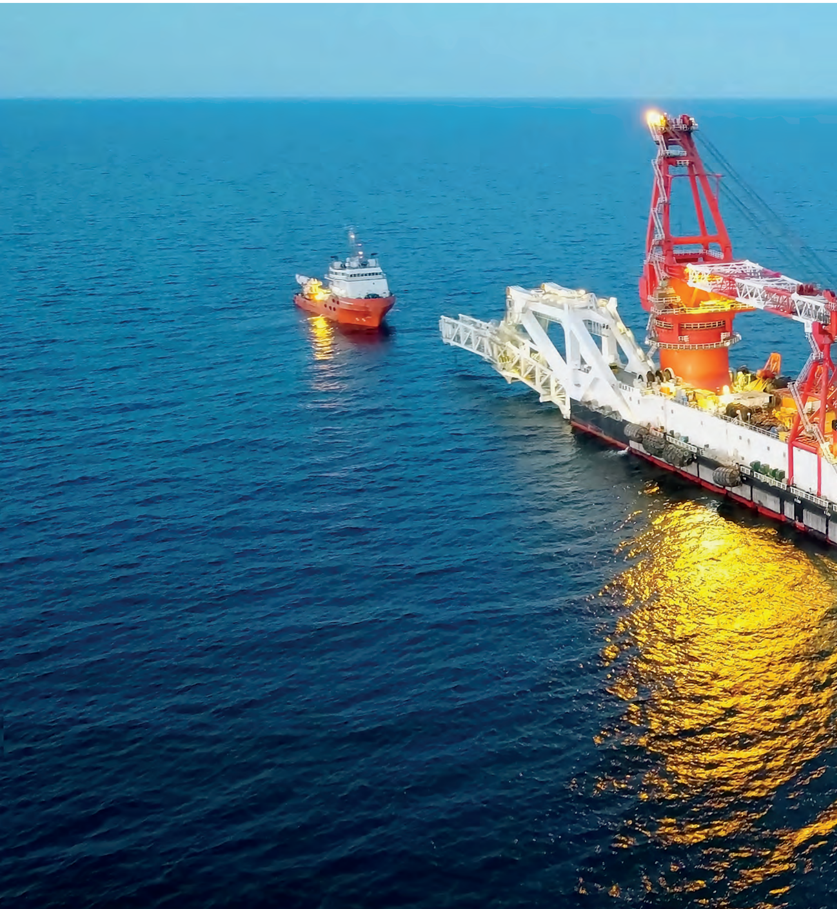
Трубоукладочные работы в рамках реализации проекта «Северный поток – 2». На снимке (слева направо): судно снабжения «Балтийский исследователь» (проект ASL-H924) и трубоукладочная баржа «Фортуна»
