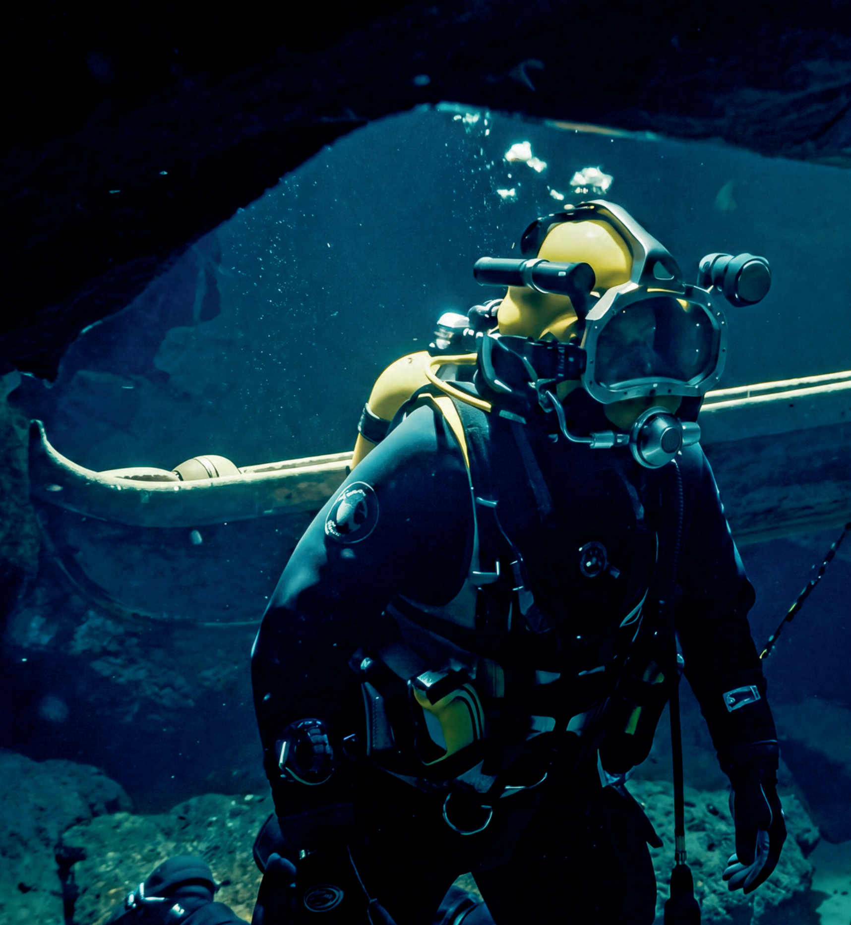
Выполнение подводно-технических работ
